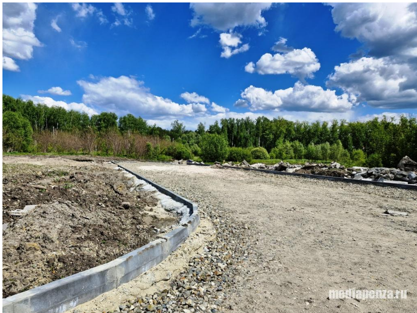
Начало работ по строительству дороги. Май 2024 года.
