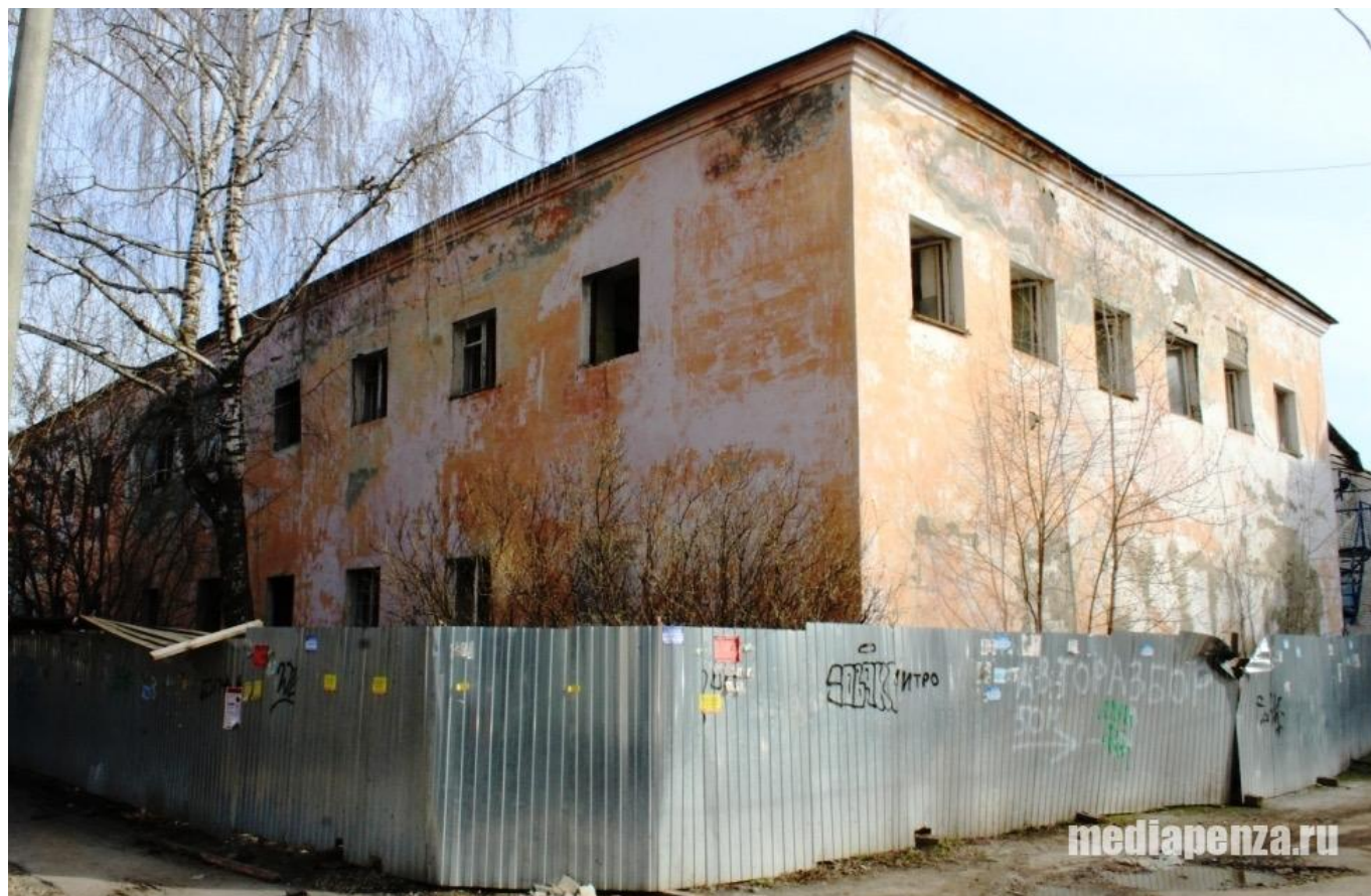
Здание общественной бани на улице Дружбы.
