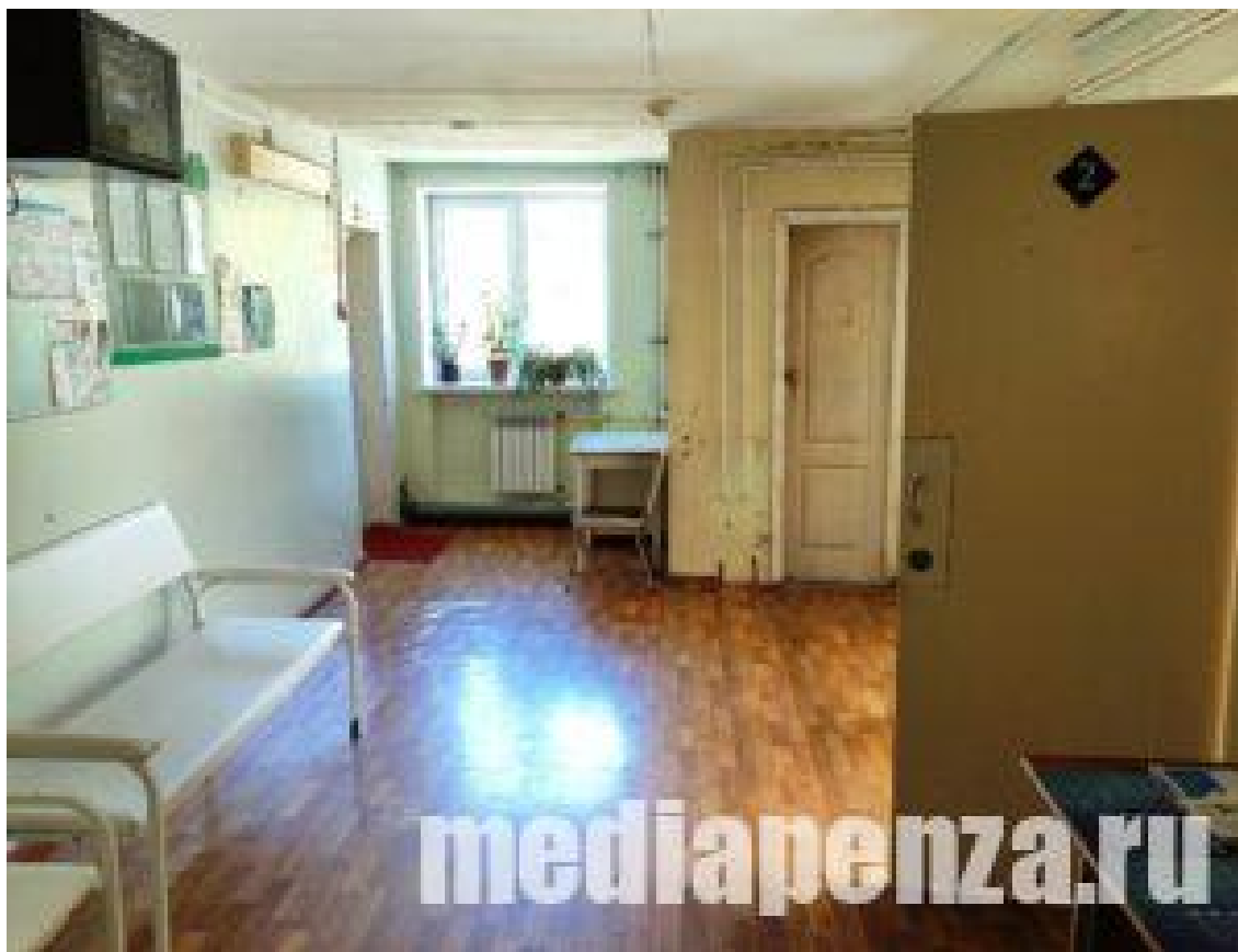
Помещение амбулатории до ремонта
